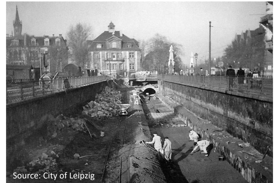
Piping of the Pleißemühlgraben in Leipzig
